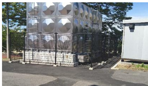
①玉川中受水槽移設更新事業（草津市）
