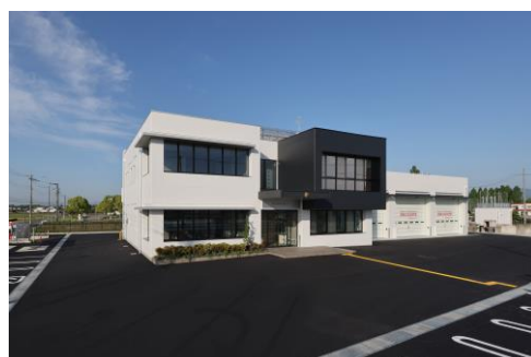
④⑤⑥ 消防・防災施設整備事業（湖南広域行政組合）
